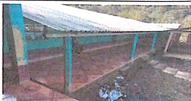
Foto 2: Colocacion de canales
