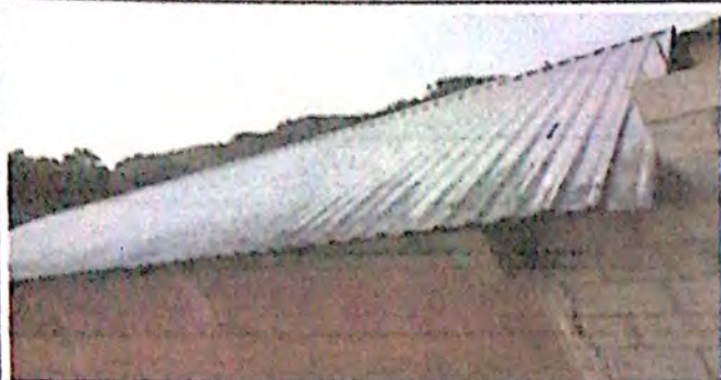
Foto 1: Cambio de techo
