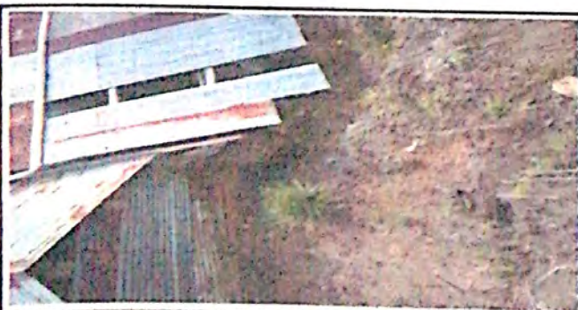
Foto 5: Cambio de techo de los tinacos
