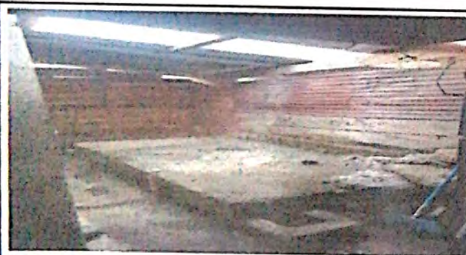
Foto 3: Cambio de techo de la cocina
