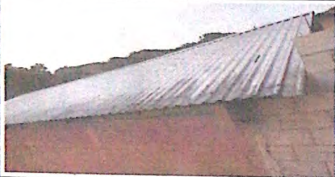
Foto 1: Cambio de techo
